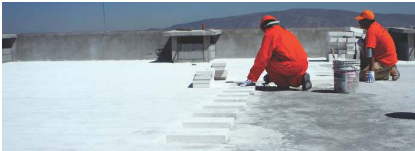
Placa Termoaislante Hebel® en techo: https://www.youtube.com/user/murosforteshebel
