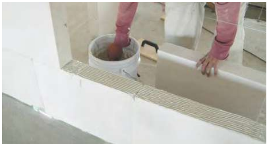
Fig. 8: Aplicación de Adhesivo Hebel.
