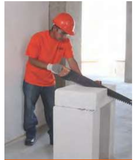
Fig. 9: Corte con serrucho Hebel.
