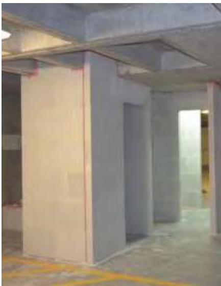
Fig. 17: Dintel y juntas de dilatación.
