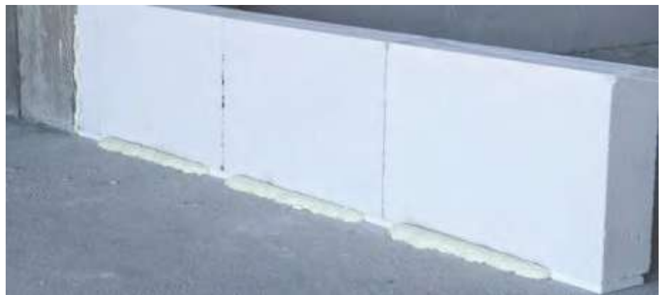
Fig. 6: Expansión de espuma de poliuretano en desplante.
