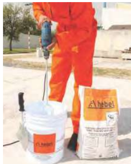
Fig. 2: Preparación de Adhesivo Hebel.
