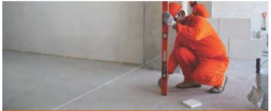
Fig. 3: Trazo y plomo para desplante.
