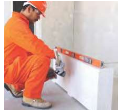
Fig. 4: Iniciar el desplante, colocando calzas.
