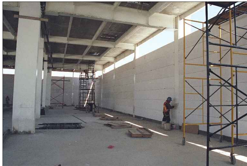
SELLADO DE JUNTAS DE EXPANSION MURO-COLUMNNA
