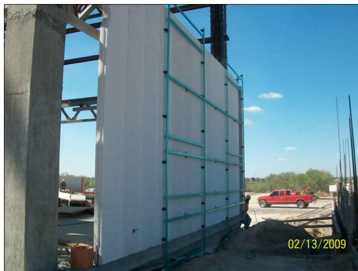
ANCLAJE DE BSATIDOR METALICO A MURO HEBEL
