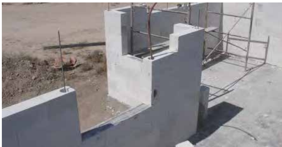
Fig. 26: Mampostería reforzada interiormente.
