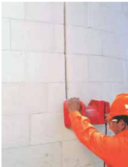
Fig. 25: Ranurador eléctrico Macroza.
