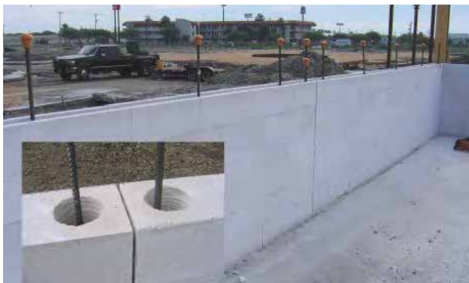
Fig. 17: Junta de control en muro.
