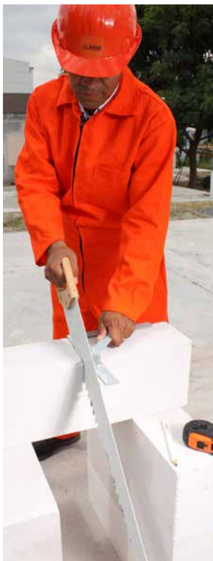
Fig. 16: Corte con serrucho y escuadra.
