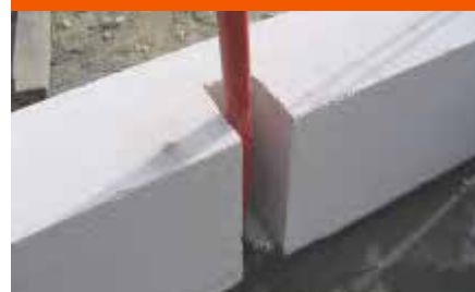
Fig. 22B: Resaque para tubería y mangueras.
