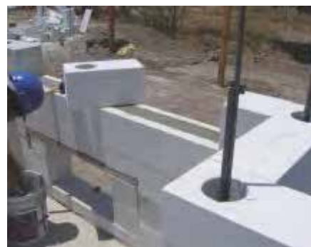
Fig. 21 Refuerzo vertical y horizontal de mampostería.
