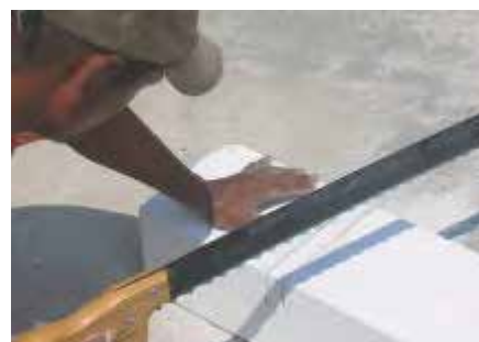
Fig. 22A: Corte con serrucho.
