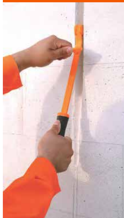
Fig. 22C: Ranurado para instalaciones de servicio.
