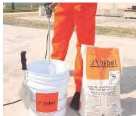
Fig. 6: Mezclado de Adhesivo Hebel.
