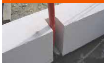
Fig. 22B: Resaque para tubería y mangueras.
