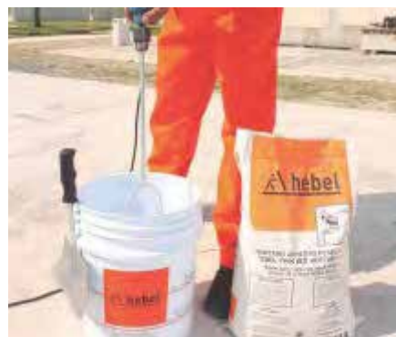
Fig. 6: Mezclado de Adhesivo Hebel.
