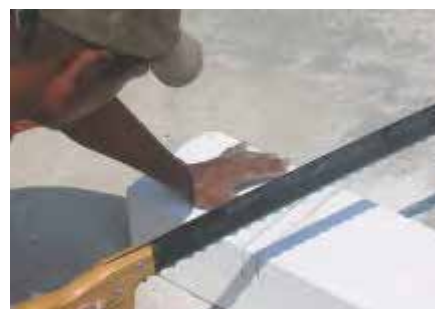
Fig. 22A: Corte con serrucho.
