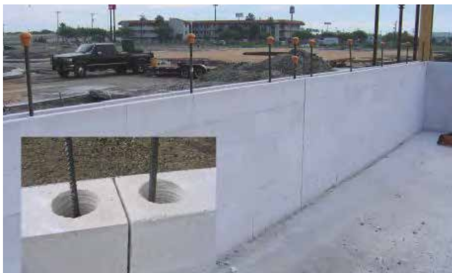
Fig. 17: Junta de control en muro.
