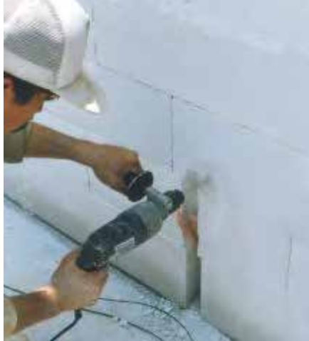
Fig. 24: Ranurador circular para contactos y salidas eléctricas.
