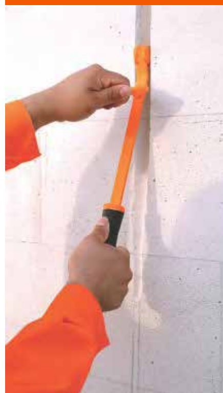
Fig. 22C: Ranurado para instalaciones de servicio.
