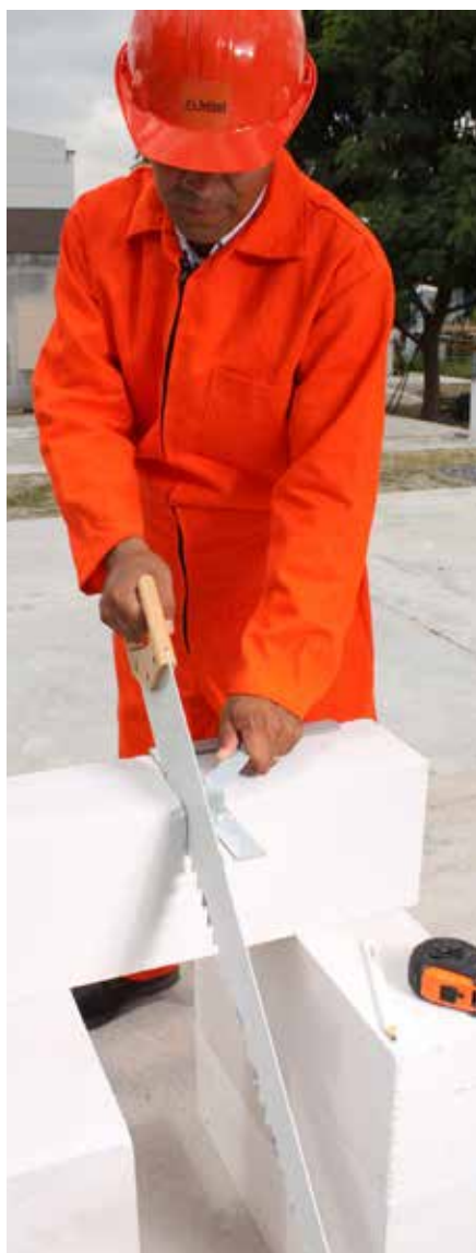
Fig. 16: Corte con serrucho y escuadra.
