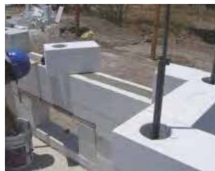
Fig. 21 Refuerzo vertical y horizontal de mampostería.
