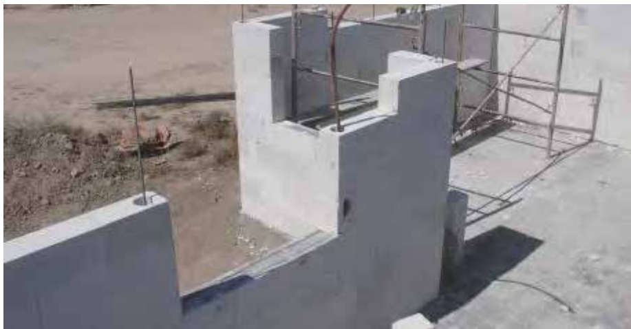
Fig. 26: Mampostería reforzada interiormente.
