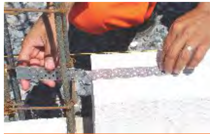
Fig. 10: Láminilla conectora.
