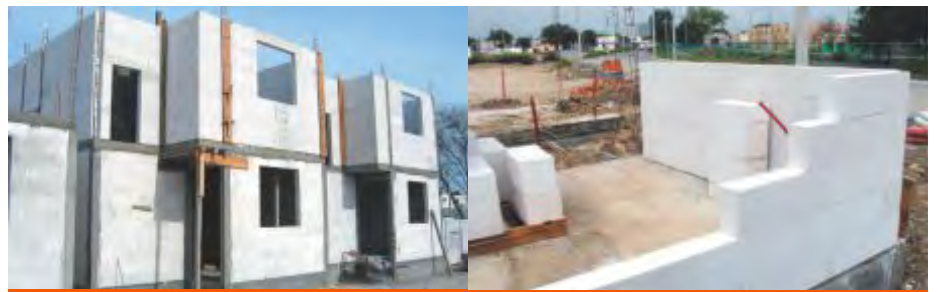
Fig. 15: Mampostería Confinada Hebel®.
