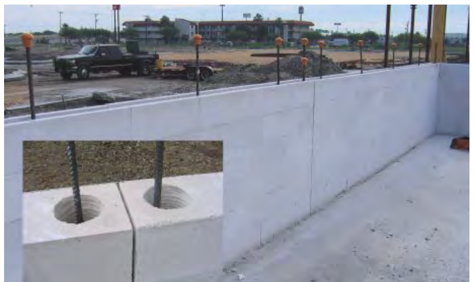
Fig. 17: Junta de control en muro.
