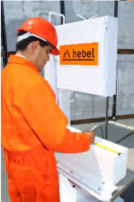
Fig. 16: Corte con serrucho y sierra eléctrica.
