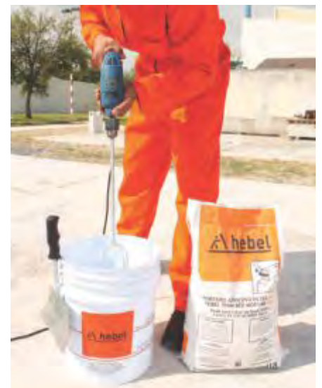
Fig. 2: Preparación de Adhesivo Hebel.
