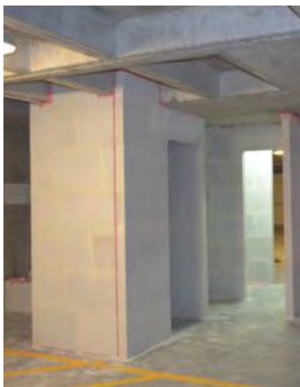
Fig. 17: Dintel y juntas de dilatación.
