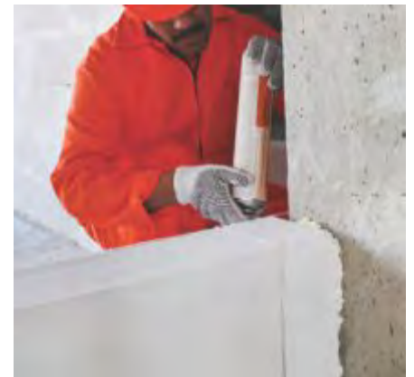
Fig. 5: Espuma Hebel en cara vertical.
