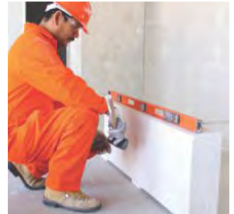
Fig. 4: Iniciar el desplante, colocando calzas.
