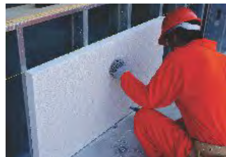
Fig. 10 Atornillado en postes centrales.
