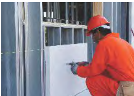
Fig. 9 Instalación de primera pieza.
