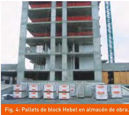
Fig. 4: Pallets de block Hebel en almacén de obra.
