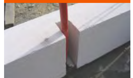
Fig. 22B: Resaque para tubería y mangueras.
