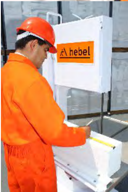
Fig. 16: Corte con serrucho y sierra eléctrica.
