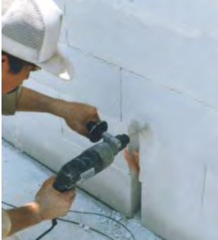
Fig. 24: Ranurador circular para contactos y salidas eléctricas.
