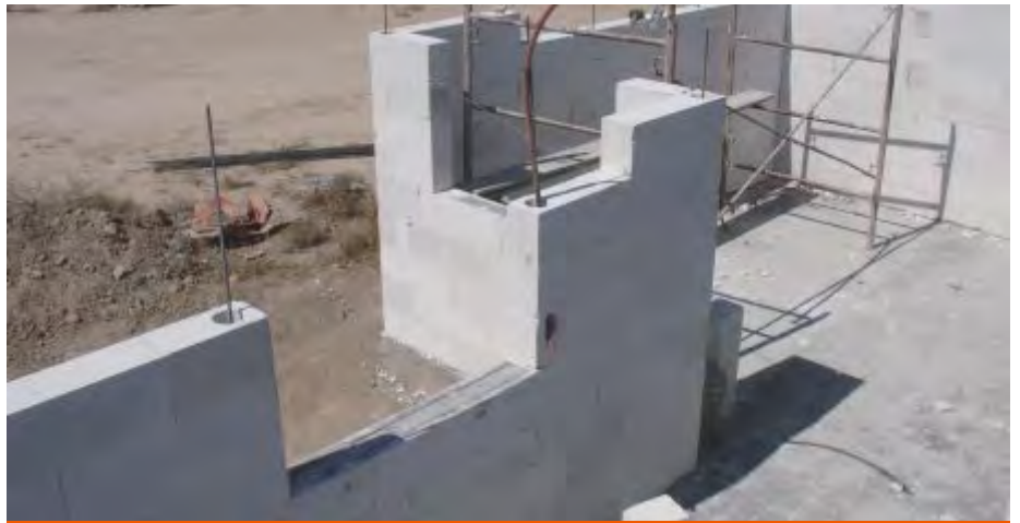
Fig. 26: Mampostería reforzada interiormente.
