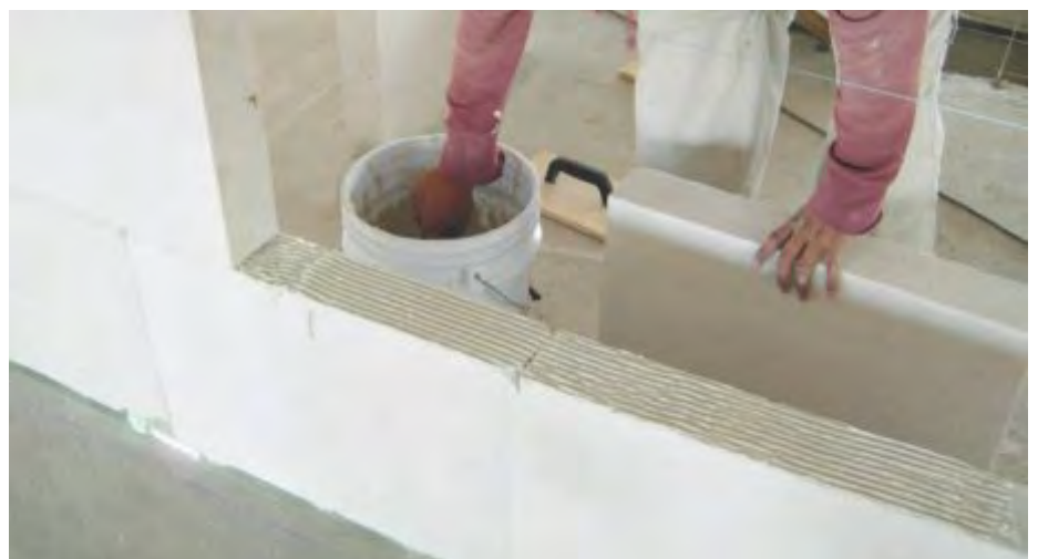
Fig. 8: Aplicación de Adhesivo Hebel.
