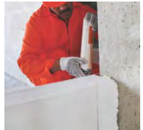
Fig. 5: Espuma Hebel en cara vertical.
