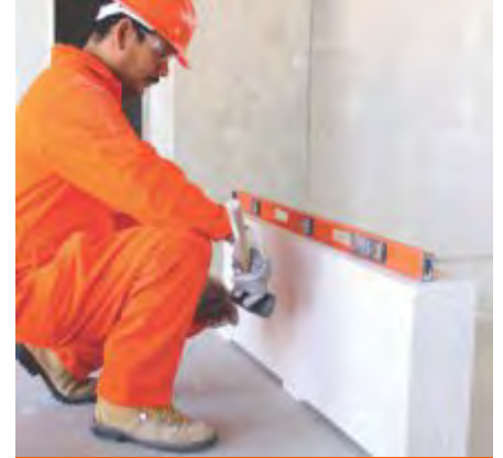
Fig. 4: Iniciar el desplante, colocando calzas.
