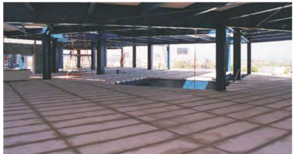
Fig. 25: Junta superior entre paneles colados y afinados.
