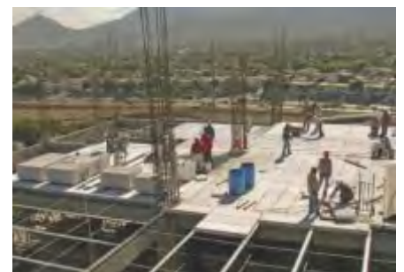
Fig. 10: Revisar la alineación de los paneles y tableros.
