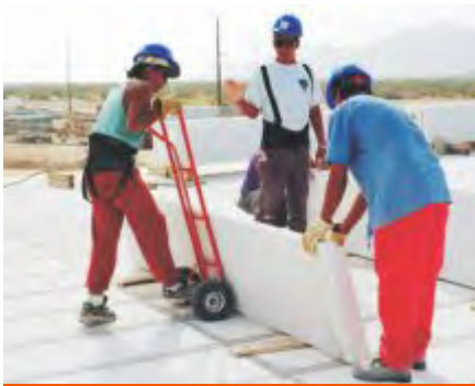
Fig. 5: Colocación del panel sobre el "diablito".
