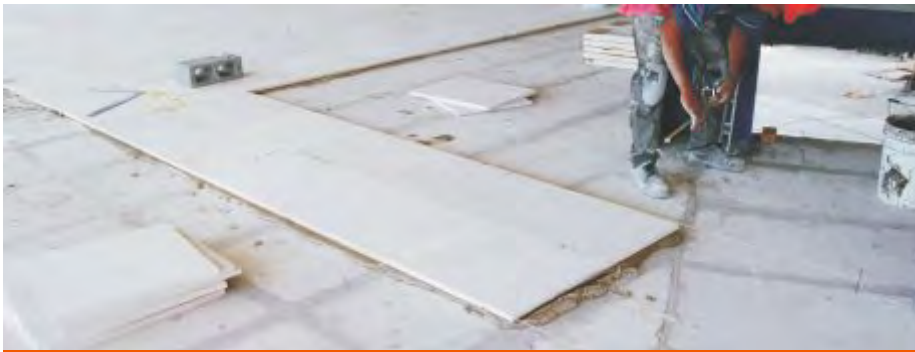
Fig. 21: Colocación directa de piso sobre panel Hebel.
